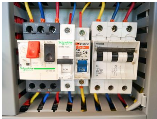
2. Encender los totalizadores secundarios y oprimir el botón START (color negro) del guardamotor.
